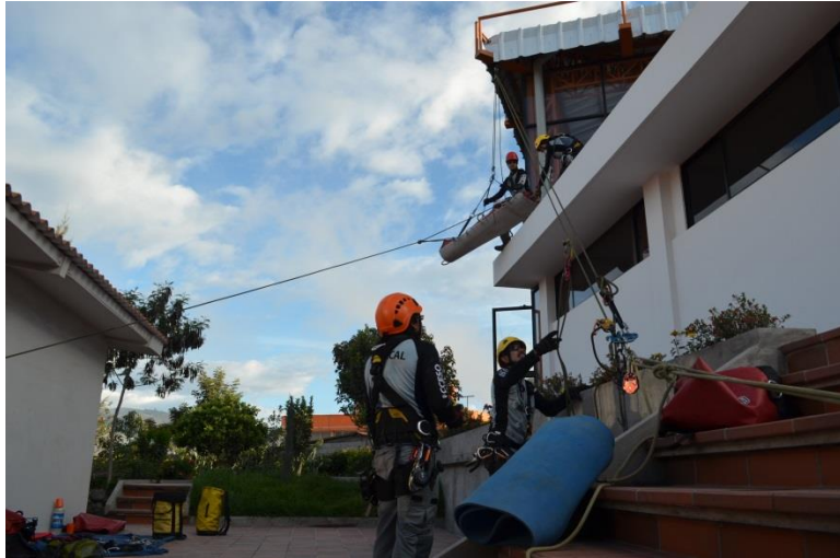
Ilustración 105.- 15.1.3. Evacuación por tirolesa en ascenso Fotografía: Roberto Gutiérrez Figueroa
