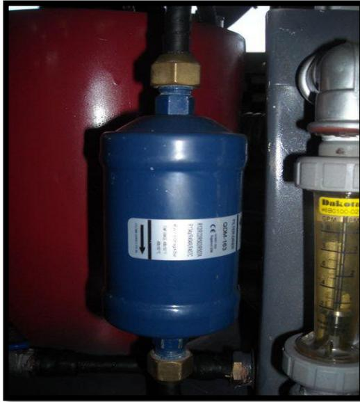
**Figura 2. 20** Filtro de secador
