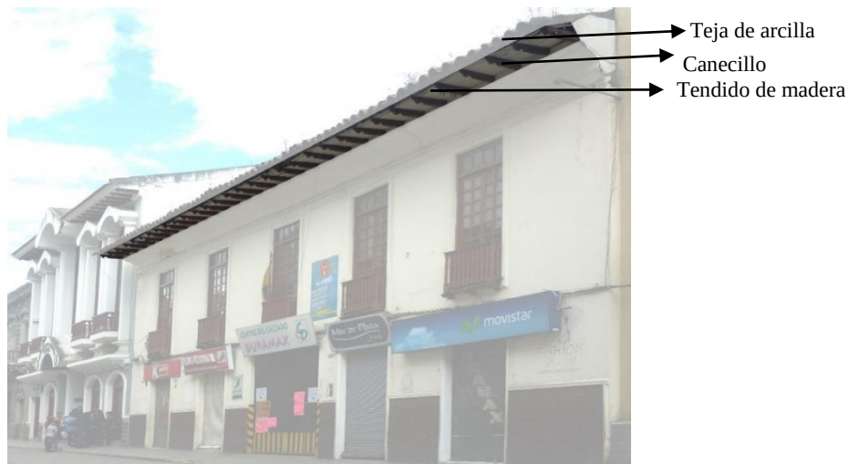
Ilustración 103. Alero del inmueble analizado
