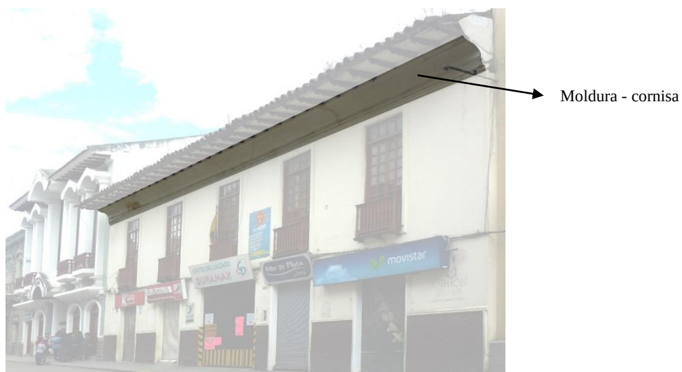
Ilustración 104. Moldura del inmueble analizado
