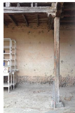
Imagen pilares encontrados en el tercer patio
