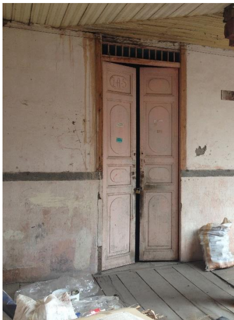
Imagen de puerta ubicada el segundo piso del segundo patio
