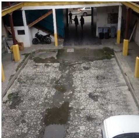
Imagen del piso de hormigón en el primer patio
