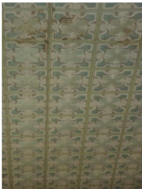
Imagen del cielo raso de metal
