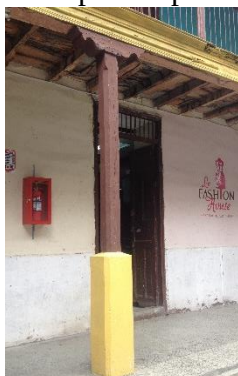
Imagen pilares encontrados en el primer patio
