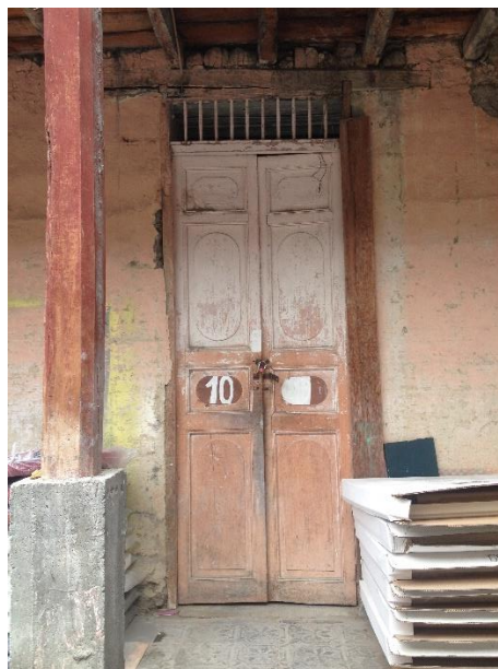
Imagen de puerta ubicada el primer piso del segundo patio
