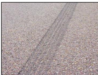
Figura. 24. Huella de Frenado
