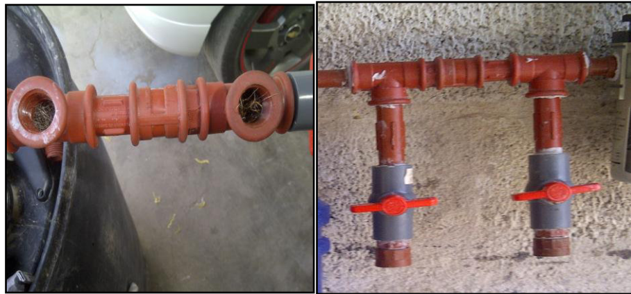
Figura 4. 23 Filtro de \text{H}_2\text{S}
