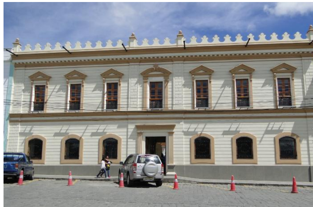
Fachada de la Casona Municipal
