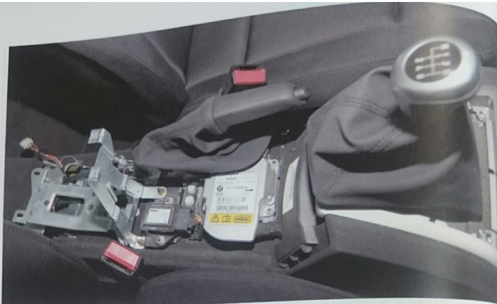
Ubicación de la unidad de control
