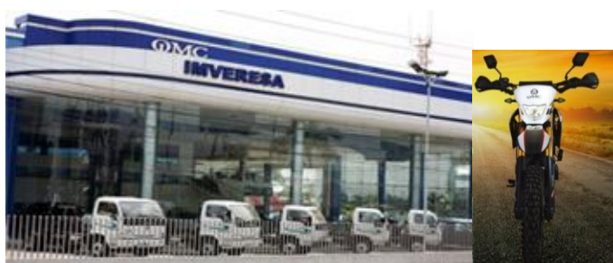
Figura 24 Instalaciones de Imveresa
