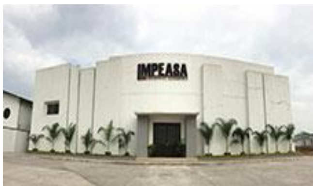
Figura 22 Instalaciones de Impeasa
