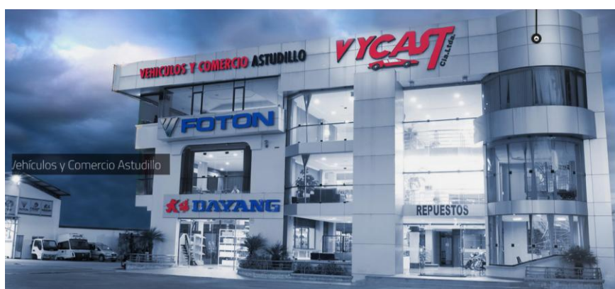
Figura 30 Instalaciones de VYCAST
