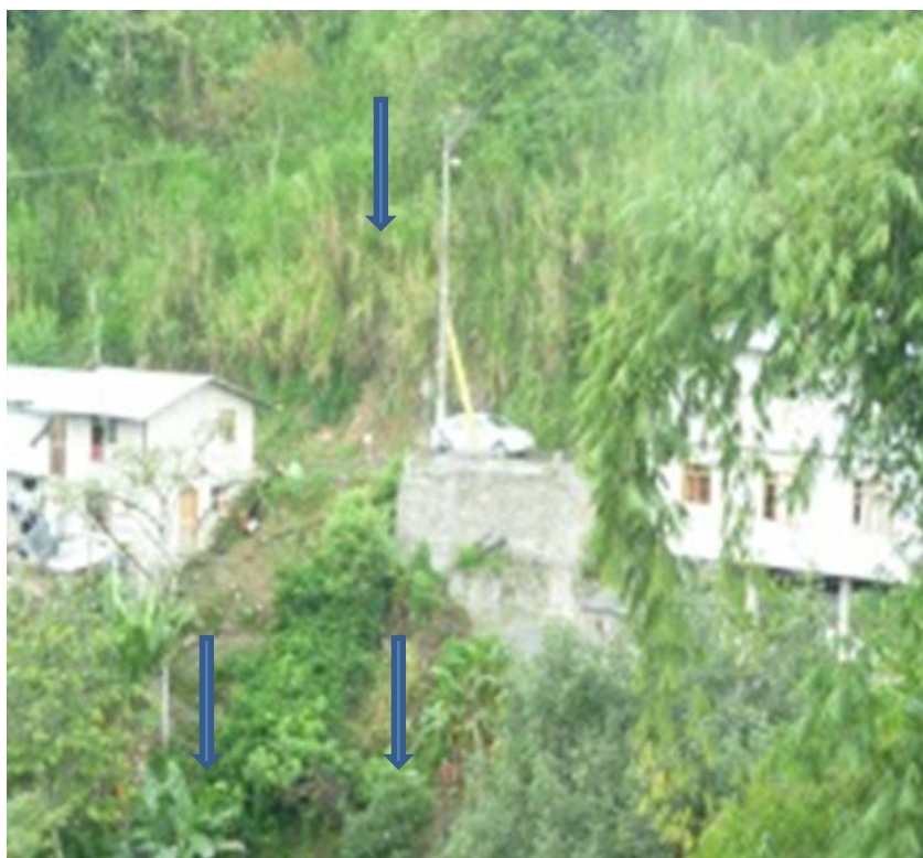
Margen derecho entrada a Nanegalito viviendas en zona de riesgo
