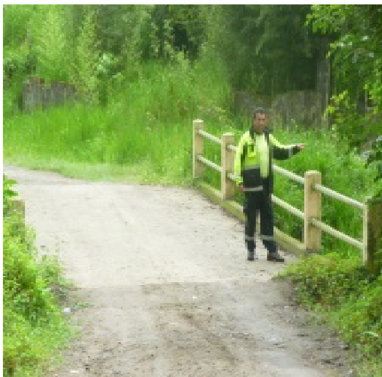
Entrada al barrio "Los Puentes". Puente sobre el río Alambi, junto al OCP
