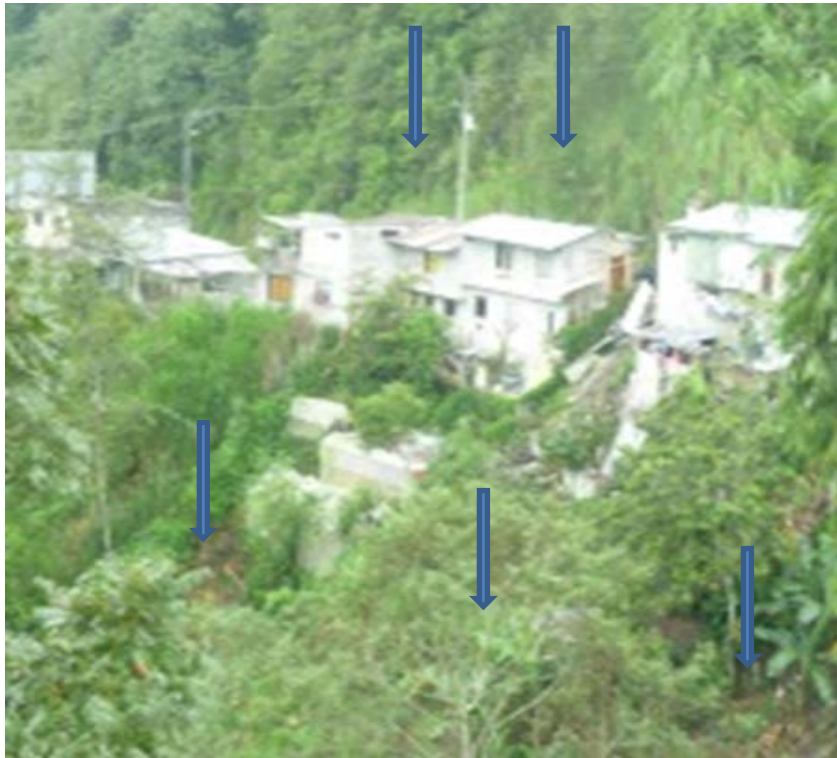
Viviendas en laderas inestables, barrio Hospitalario vía principal Calacali, Nanegalito
