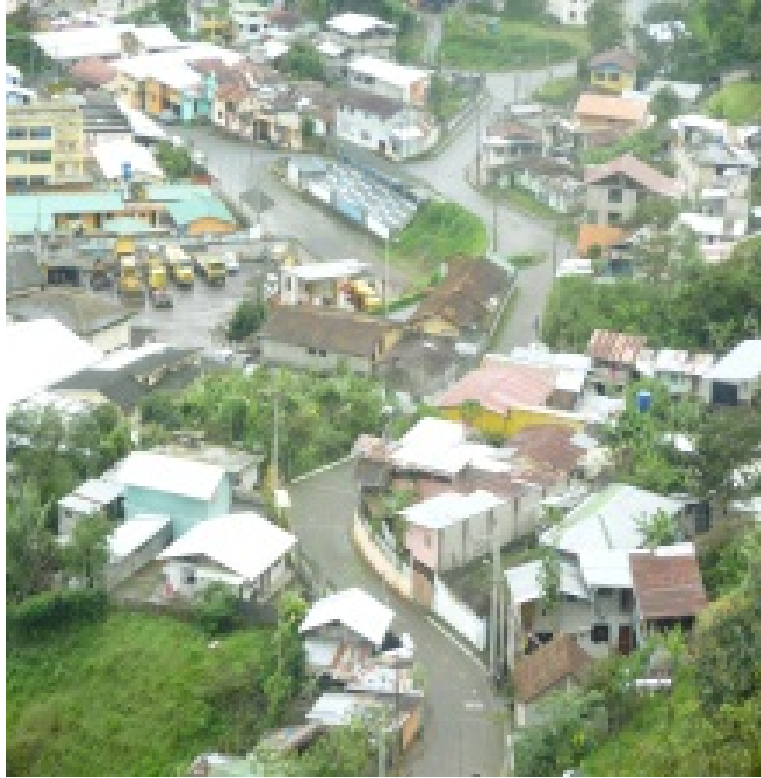
Barrio San Francisco asentado en laderas inestables
