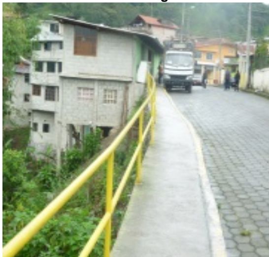
Viviendas ubicadas en zonas inseguras
