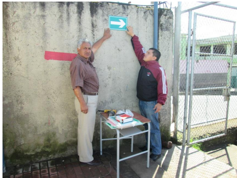
Fotografía 30. Instalación de señalética #4 Fuente: Registro fotográfico propio
