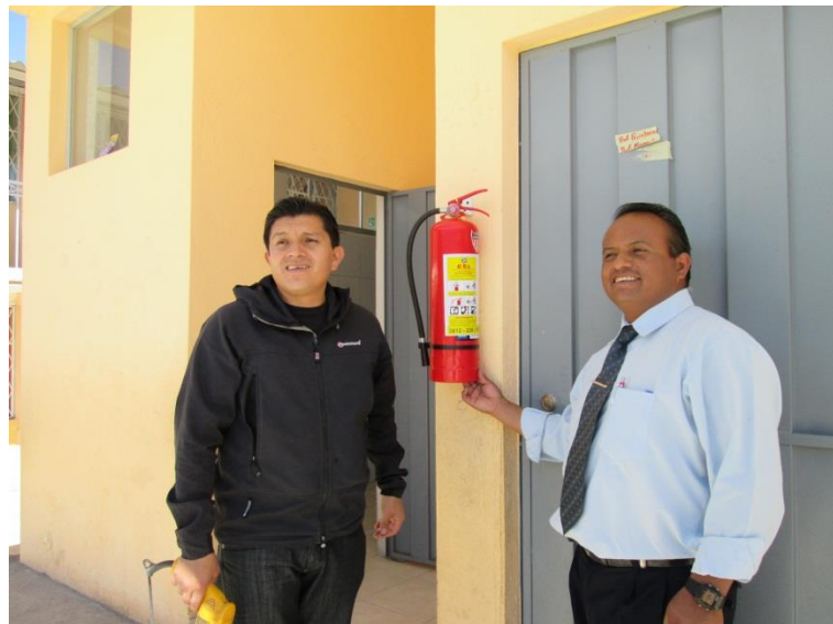
Fotografía 34. Instalación de extintores #3 Fuente: Registro fotográfico propio
