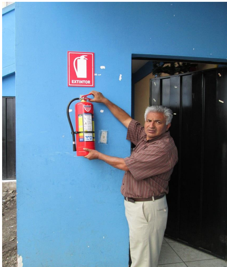
Fotografía 32. Instalación de extintores #1 Fuente: Registro fotográfico propio
