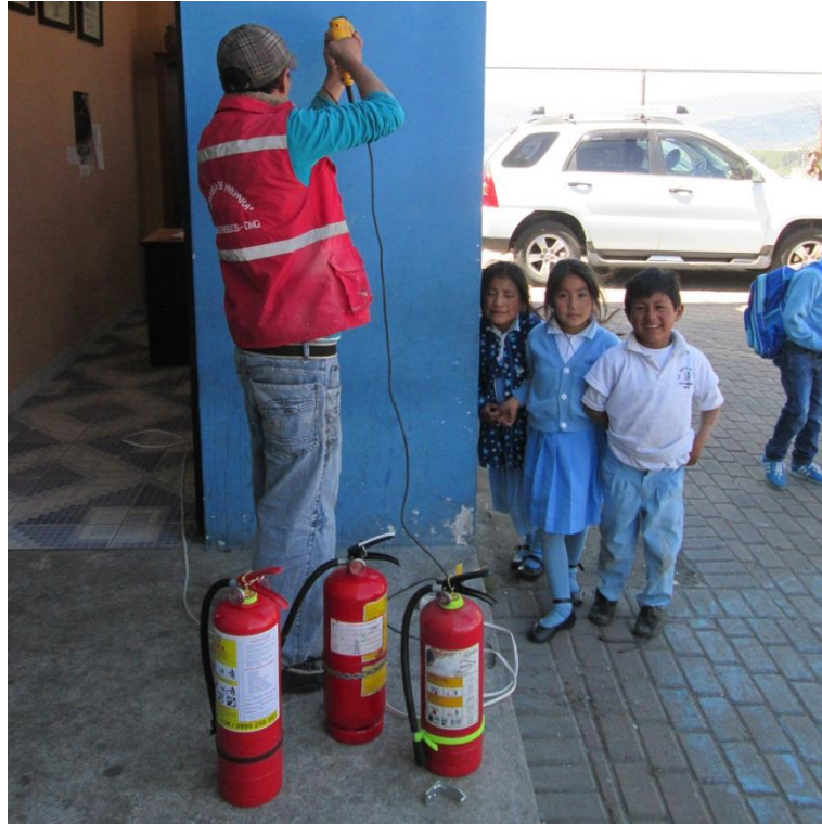
Fotografía 35. Instalación de extintores #4 Fuente: Registro fotográfico propio
