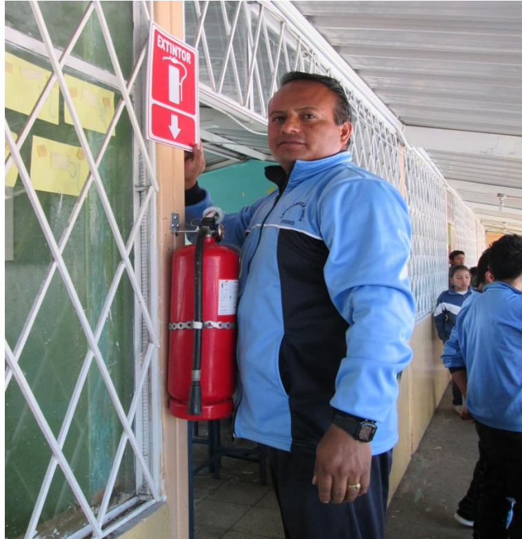
Fotografía 33. Instalación de extintores #2 Fuente: Registro fotográfico propio
