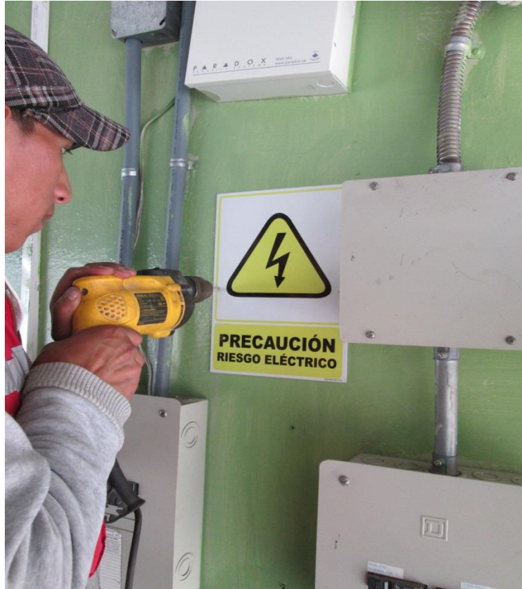
Fotografía 29. Instalación de señalética #3 Fuente: Registro fotográfico propio
