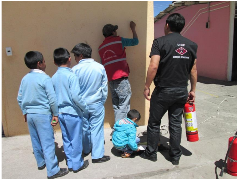
Fotografía 36. Instalación de extintores #5 Fuente: Registro fotográfico propio
