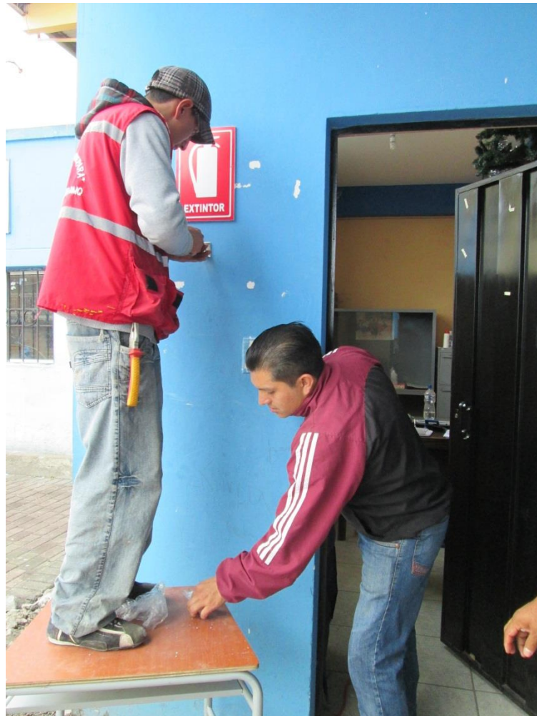
Fotografía 28. Instalación de señalética #2 Fuente: Registro fotográfico propio
