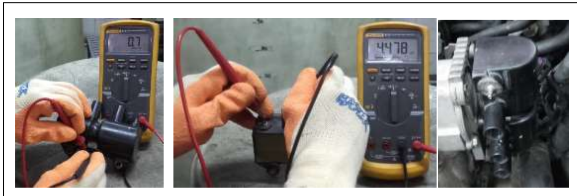
Figura 73: Medición de resistencias del primario y secundario. Bobina genérica y montaje en el motor
