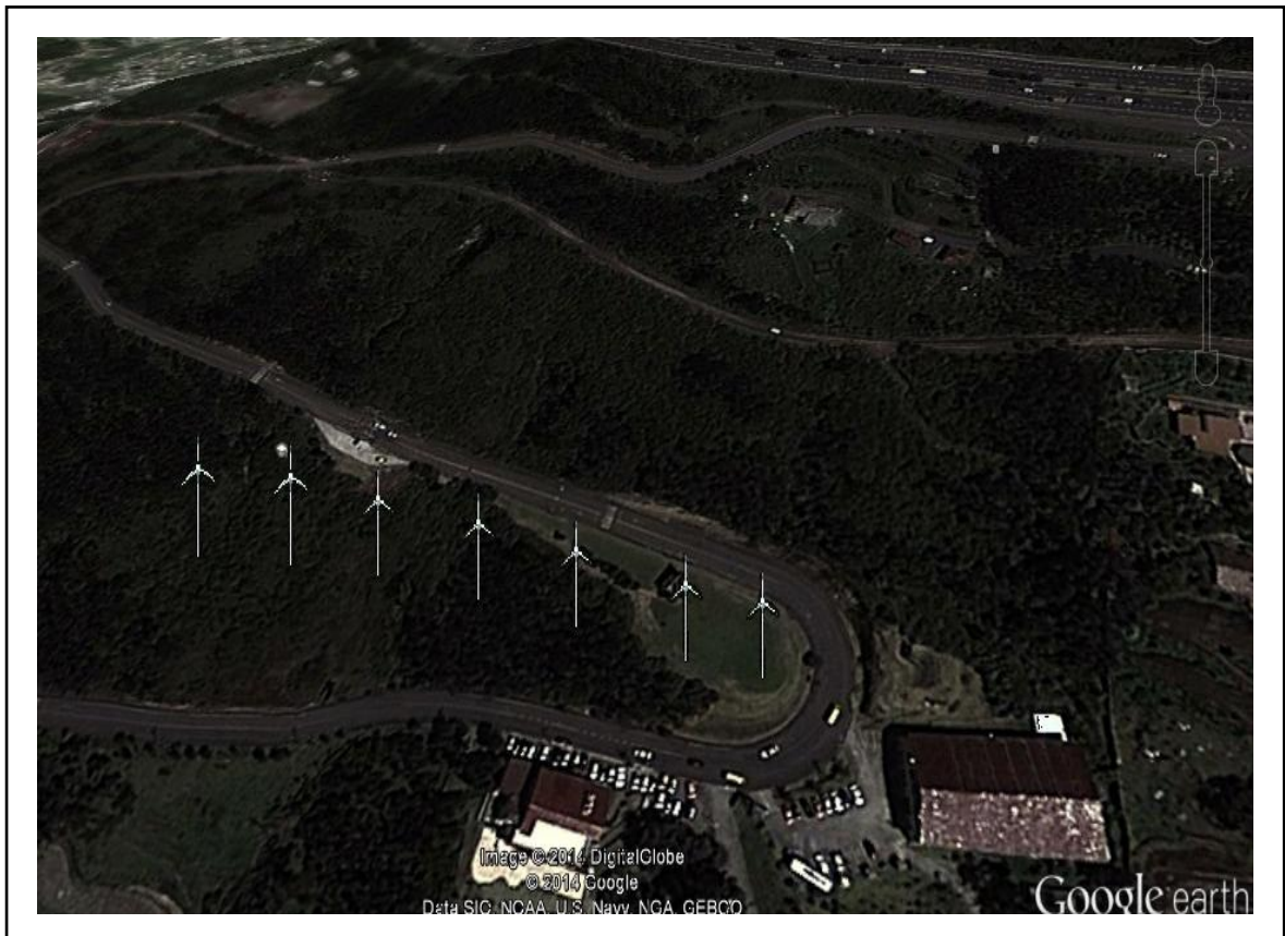
Fig. 6.4 Zona de instalación parque eólico
