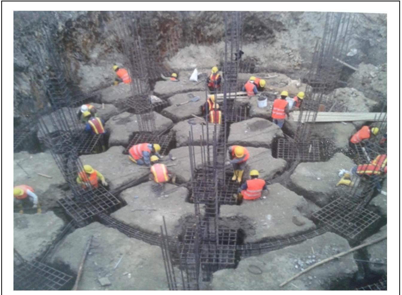
Fig. 6.8 Cimentación Parque Eolio Villonaco.
