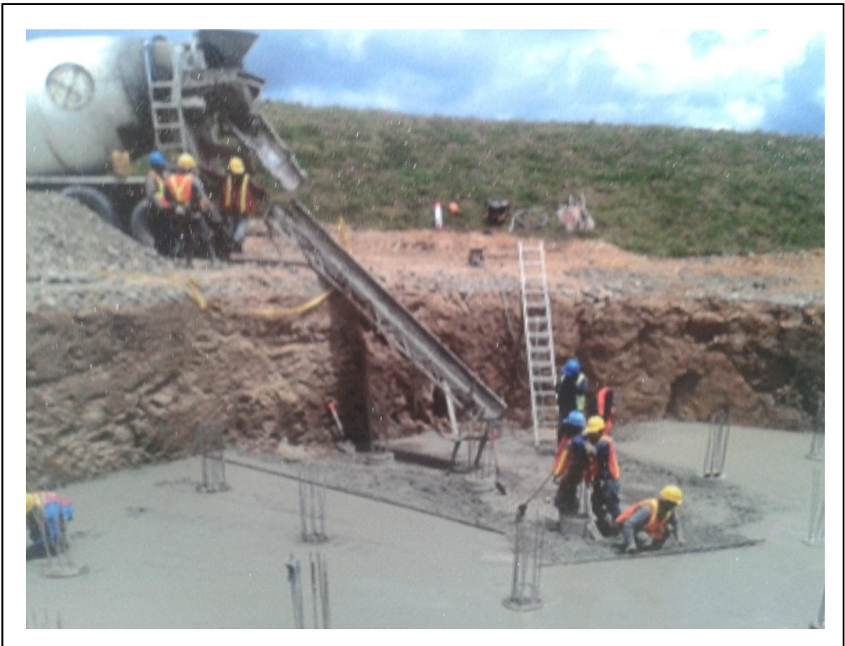
Fig. 6.9 Cimentación Parque Eolio Villonaco.
