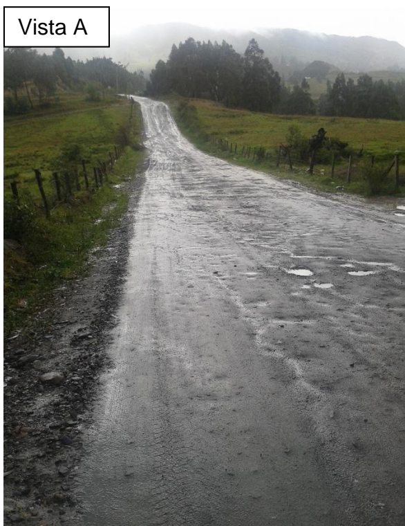
Ilustración 38. Visual desde la calle Sldo. Héctor Pilco hacia el terreno (E-O)
