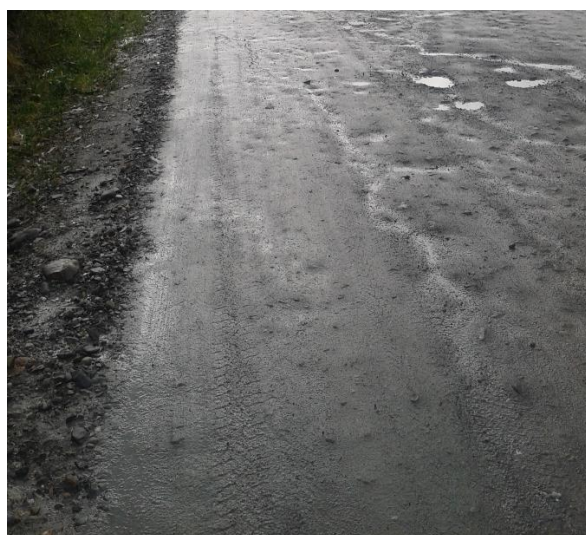
Ilustración 49. Estado de calle principal
