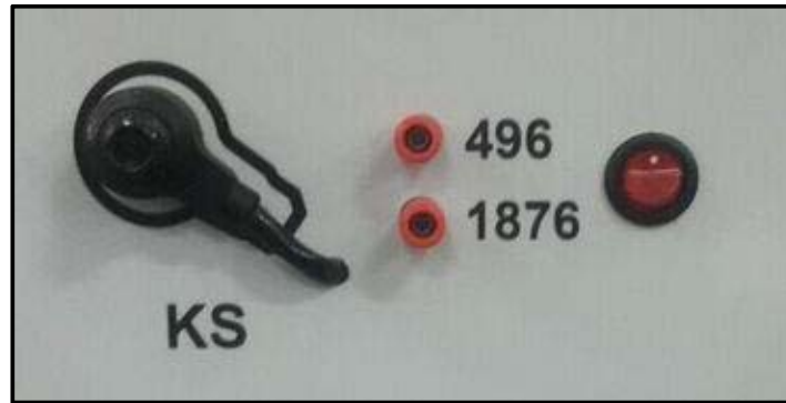
Figura 30. Instalación de sensor KS Editado por: Julio Obregón
