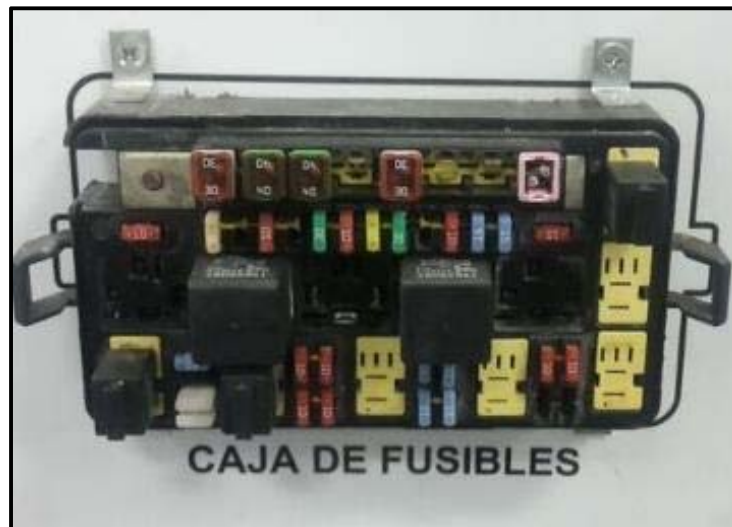
Figura 33. Instalación de caja de fusibles Autor: Julio Obregón
