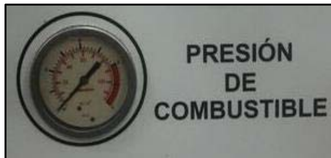
Figura 39. Instalación de manómetro de presión Editado por: Julio Obregón
