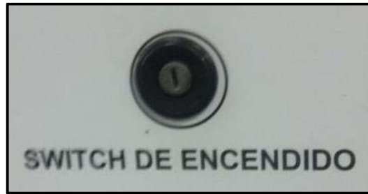
Figura 32. Instalación del switch de encendido Autor: Julio Obregón
