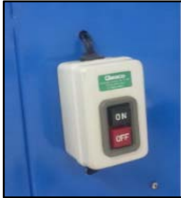
Figura 43. Instalación de interruptor principal Autor: Julio Obregón
