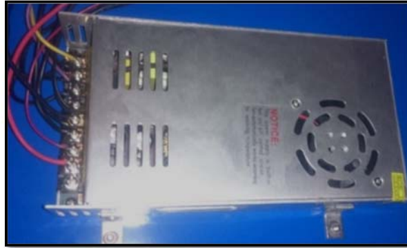
Figura 45. Instalación de fuente de poder Autor: Julio Obregón
