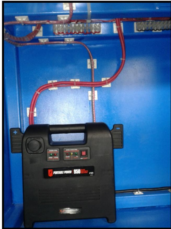
**Figura 53. Batería / Arrancador del sistema eléctrico 12 volt**
