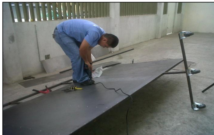
Figura 49: Proceso de remachar las planchas metálicas.
