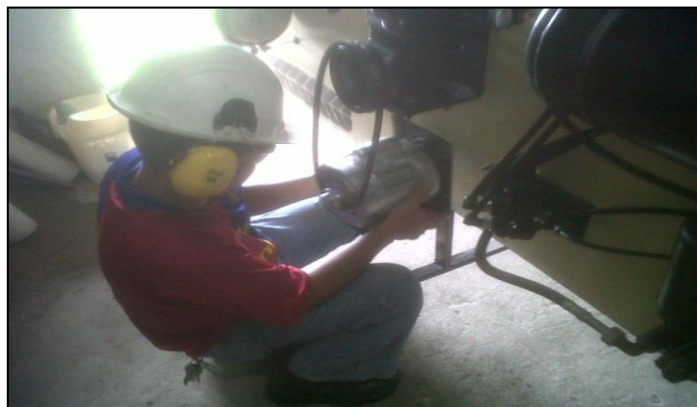
Figura 69: Regulación de la correa dentada.
