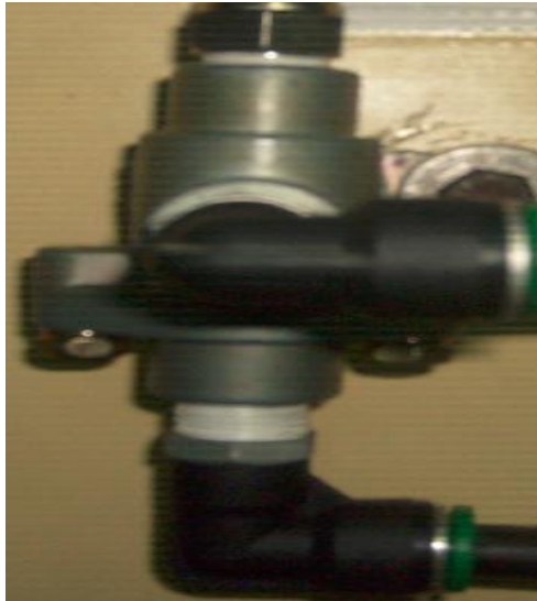
Figura 20: Válvula Check doble
