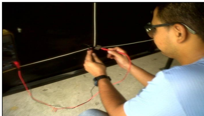
Figura 98: Prueba de corto a masa a lo largo del cableado.
