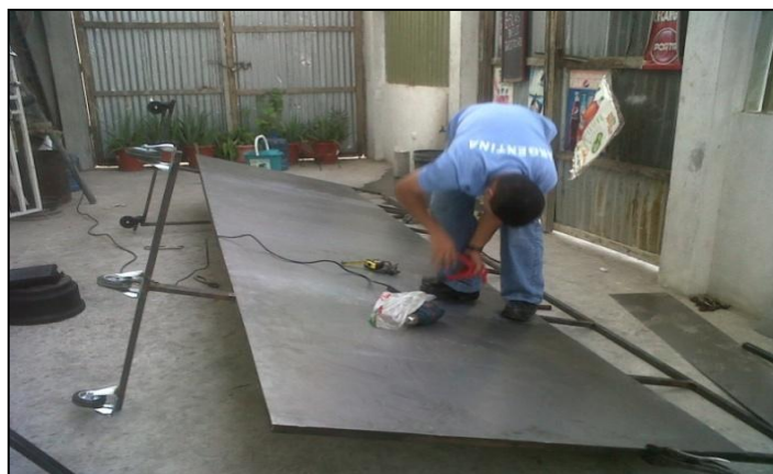
Figura 50: Proceso de remachar las planchas metálicas.
