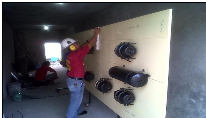
Figura 60: Instalación de componentes eje tractor del camión.
