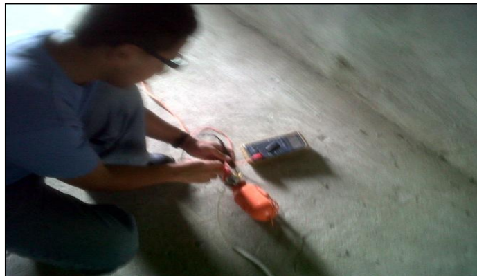
Figura 81: Comprobación de alimentación 110V AC
