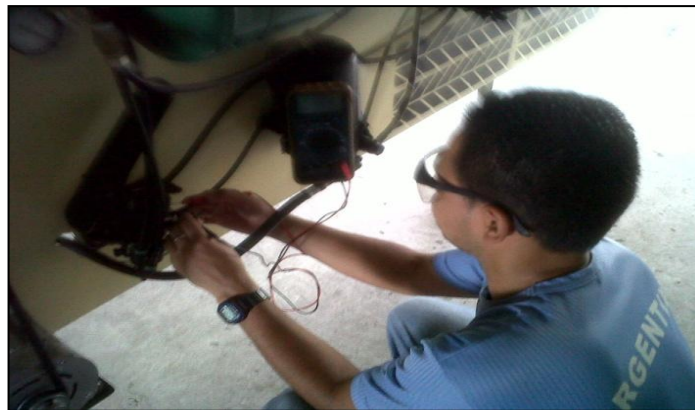
Figura 87: Prueba de corto a voltaje de interruptor de luces de stop.
