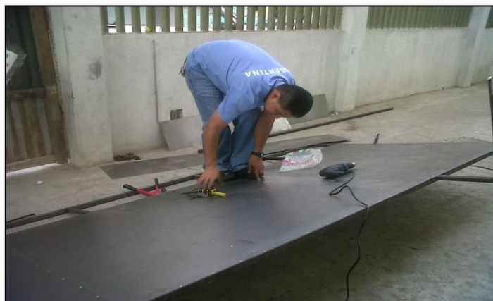
Figura 48: Proceso de remachar las planchas metálicas.
