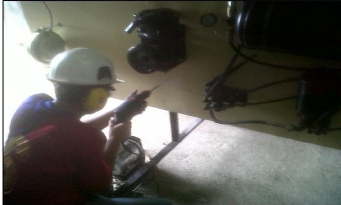
Figura 67: Instalación motor eléctrico.
