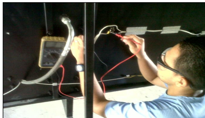
Figura 95: Prueba de corto a masa del interruptor de encendido motor eléctrico.
