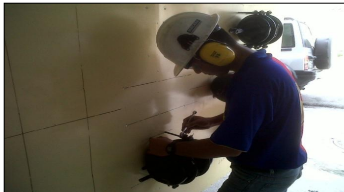
Figura 57: Instalación de los cilindros de freno (doble efecto).
