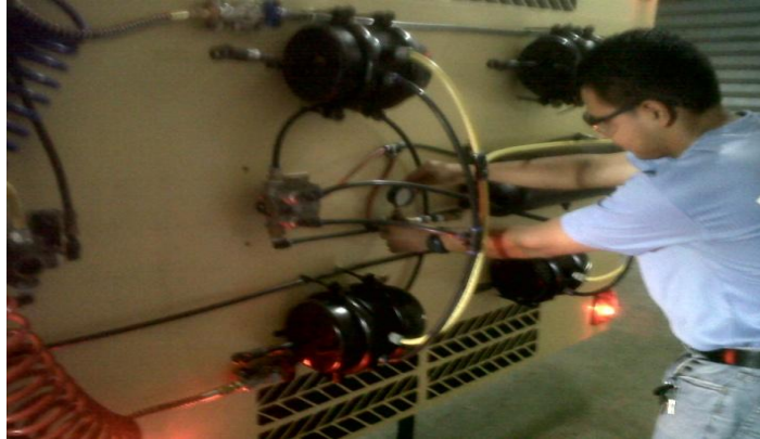
Figura 80: Verificación de manómetro.
