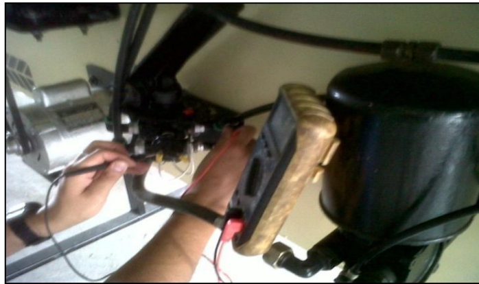
Figura 86: Prueba de continuidad en interruptor de luces de stop.
