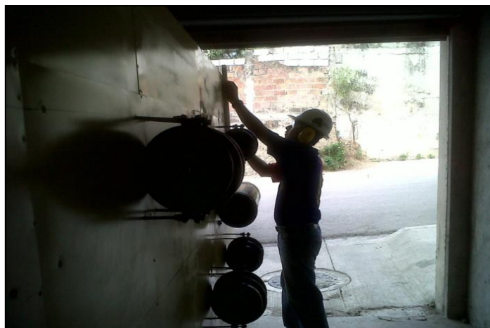
Figura 65: Instalación de componentes del camión.
