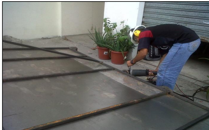
Figura 5.3: Proceso de eliminar filos cortantes utilizando una amoladora.
