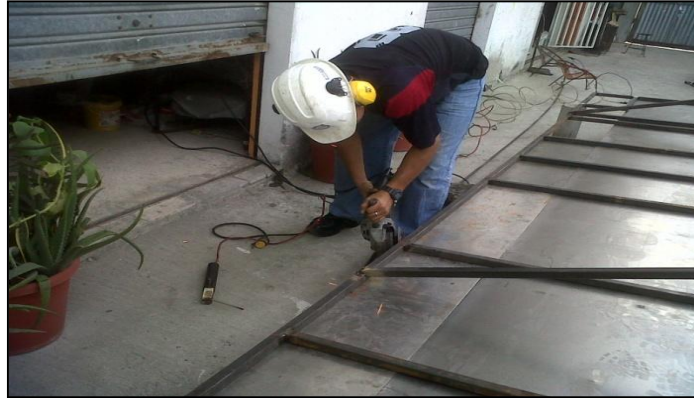
Figura 5.2: Proceso de eliminar filos cortantes utilizando una amoladora.
