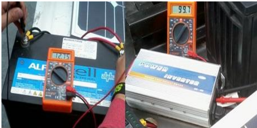
Fig. 3.38 Conexión del acumulador con el Inversor del sistema
