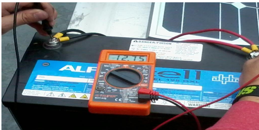
Fig. 4.5 Medición de voltaje de la Batería
