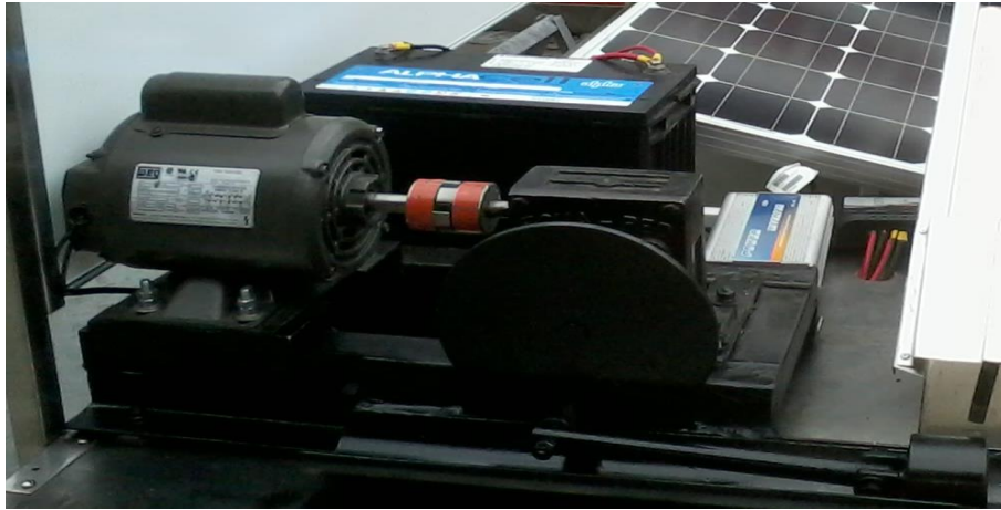
Fig. 3. 39 Conexión desde el Inversor al sistema de compactación
