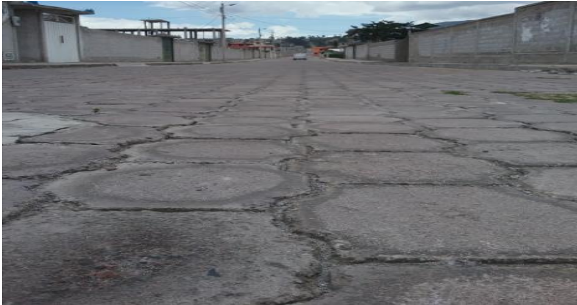
Figura 2.8: Vía con superficie adoquinada Fuente: Cevallos C., Ruiz R.
