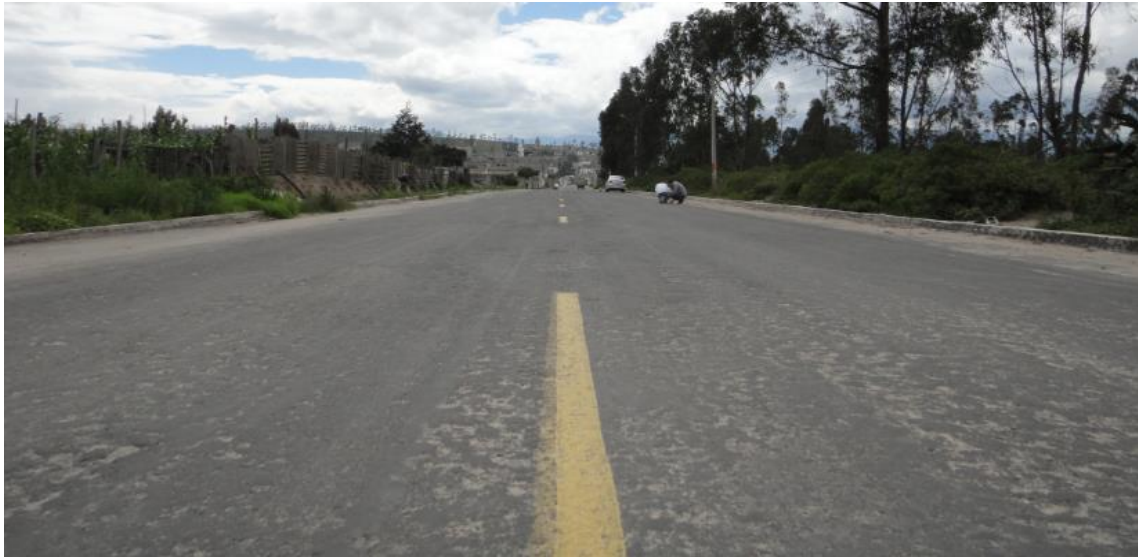
Figura 2.6: Vía con superficie asfáltica Fuente: Cevallos C., Ruiz R.
