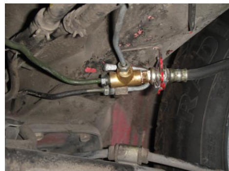
Fig. 2.7 Unión entre cañerías
