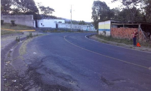
Fisuración de borde
