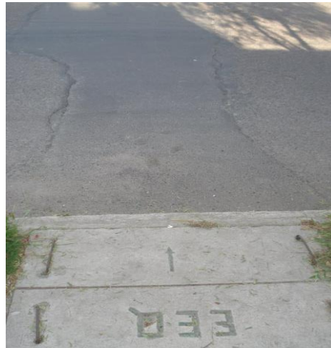
Zanjas para conectividad
