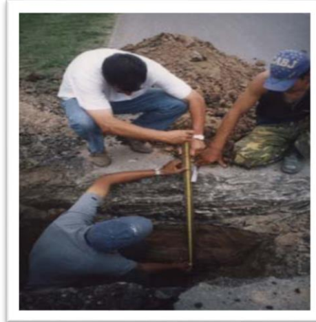
Figura 20 Toma de muestras Calicatas
