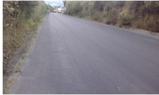
Fisuramiento longitudinal
