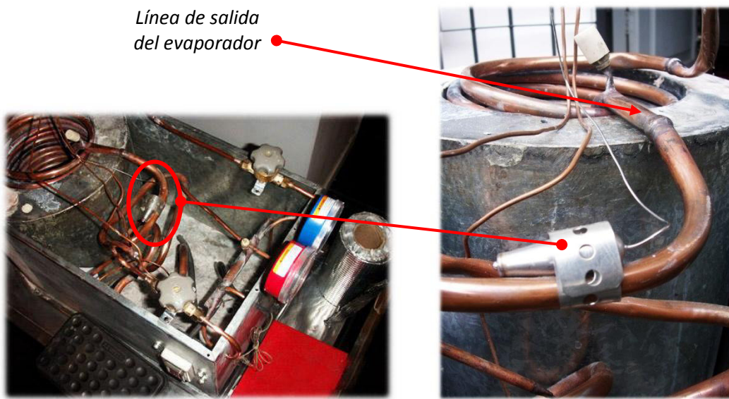
Figura 5.6. Ubicación del bulbo con sobrecalentamiento de 5°C
