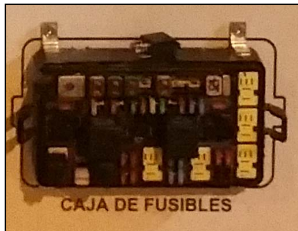
Figura 37. Montaje de la caja de fusible Autor: Rodolfo Mera
