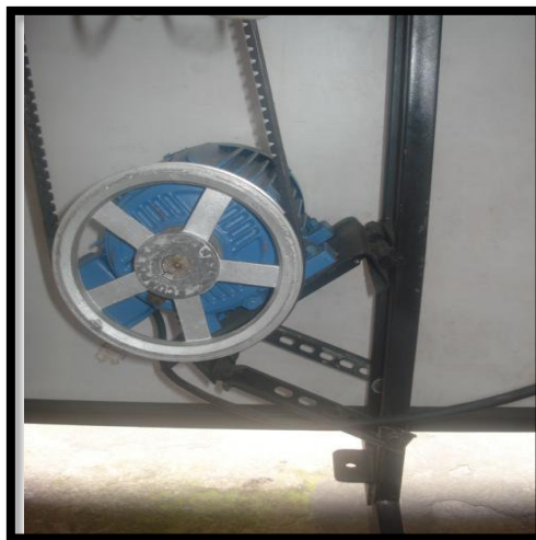
FIGURA 3.31 SUJECIÓN DEL COMPRESOR FUENTE: DIAZ, MANJARREZ
