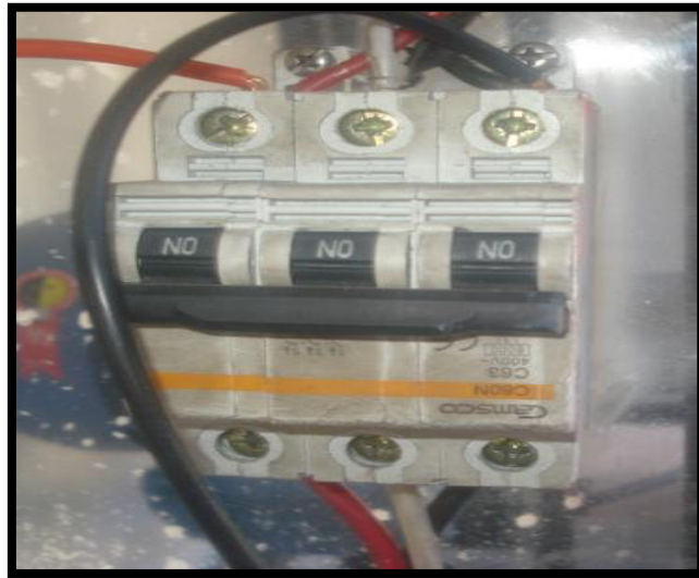
FIGURA 3.39 INTERRUPTOR TRIFÁSICO FUENTE. DÍAZ, MANJARREZ
