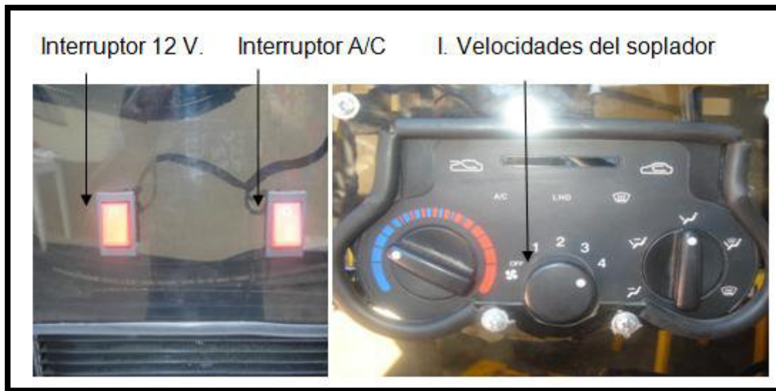
FIGURA 3.8 INTERRUPTORES FUENTE: DÍAZ, MANJARREZ
