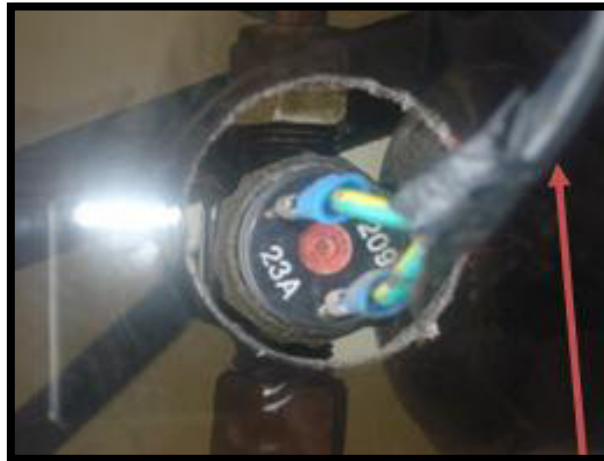
FIGURA 3.17 CONMUTADOR DE PRESIÓN FUENTE: DÍAZ, MANJARREZ
