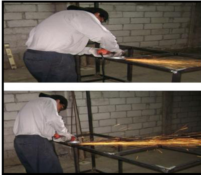
FIGURA 3.28 DESBASTE DE LA ESCORIA FUENTE: DÍAZ, MANJARREZ
