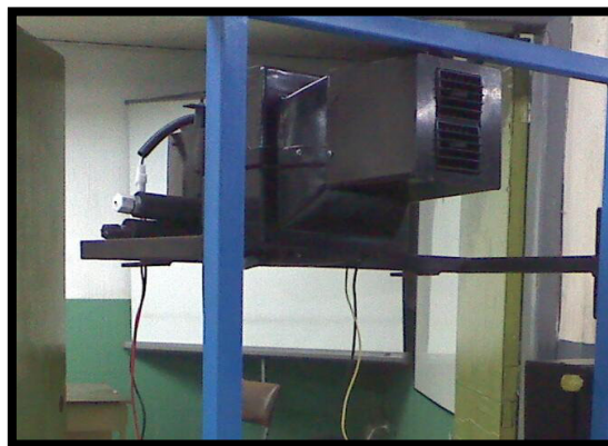
FIGURA 3.34 FIJACIÓN DEL CONJUNTO DEL EVAPORADOR FUENTE: DÍAZ, MANJARREZ
