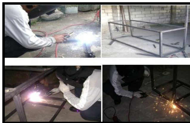
FIGURA 3.27 SUELDA DE LA ESTRUCTURA FUENTE: DÍAZ, MANJARREZ
