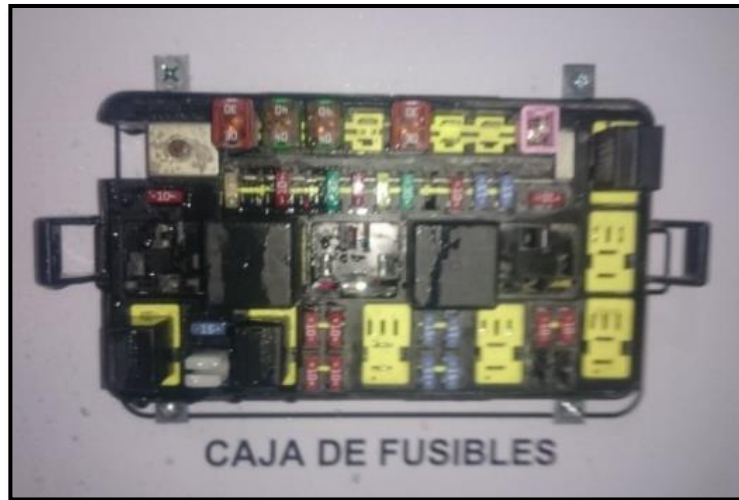
Figura 39. Instalación de la caja de fusibles Autor: Jonathan Olivo
