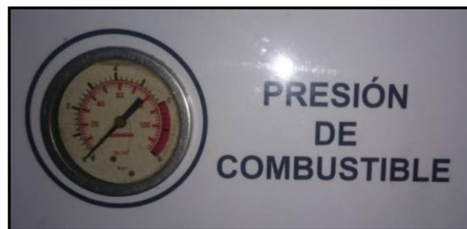
Figura 45. Instalación del manómetro Autor: Jonathan Olivo
