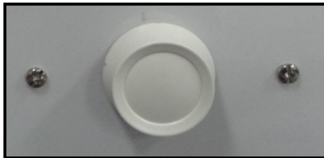
figura 71. Instalación del dimmer
