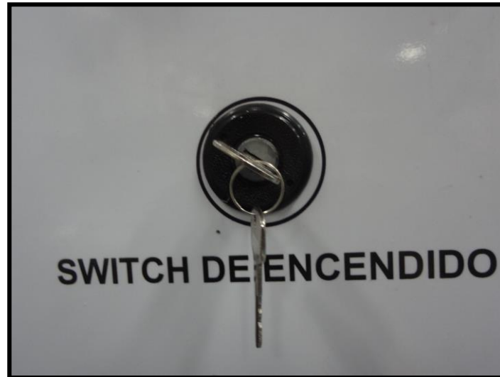
Figura 66. Instalación switch encendido
