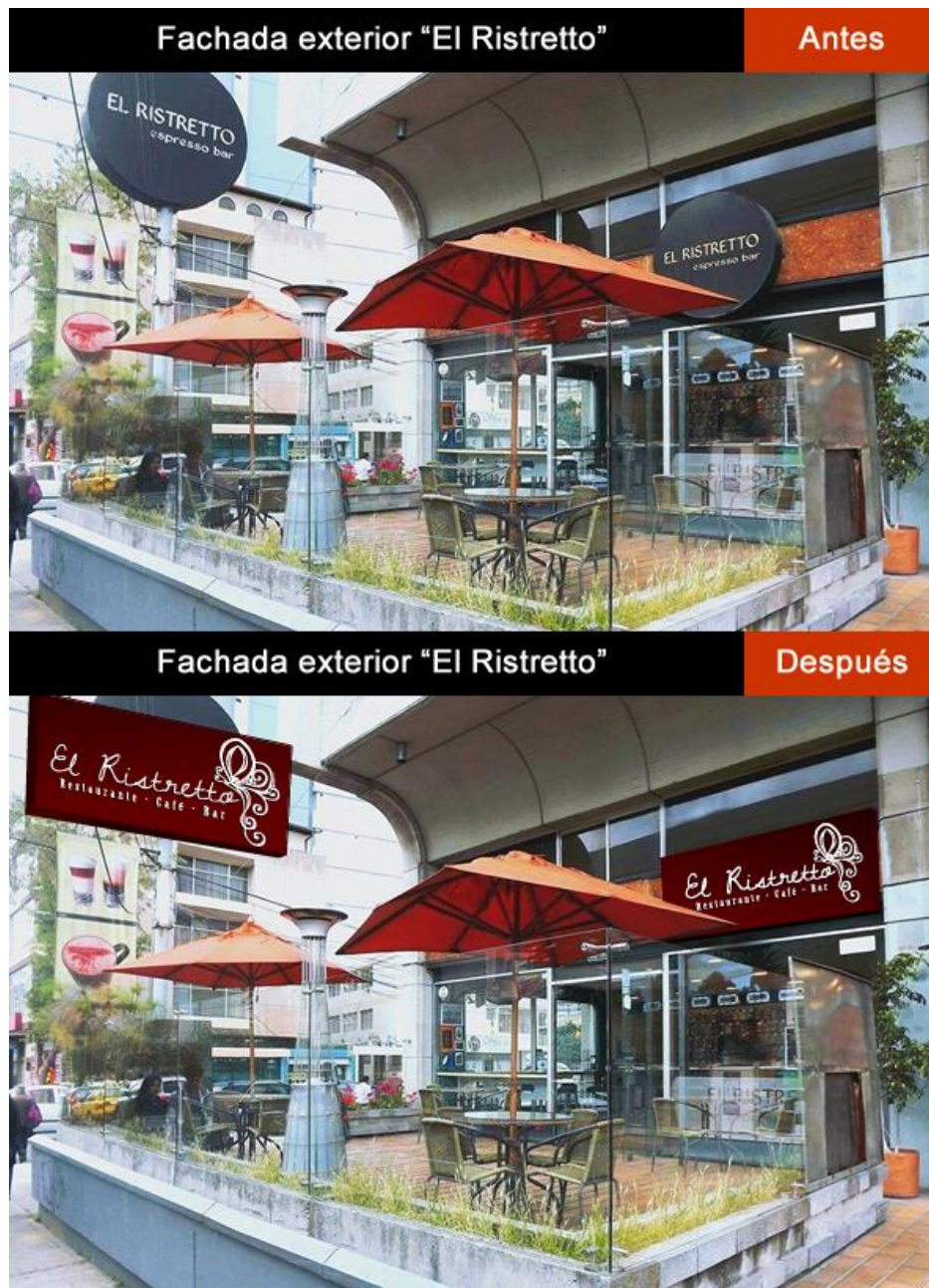
Figura 30. Imagen fachada exterior
