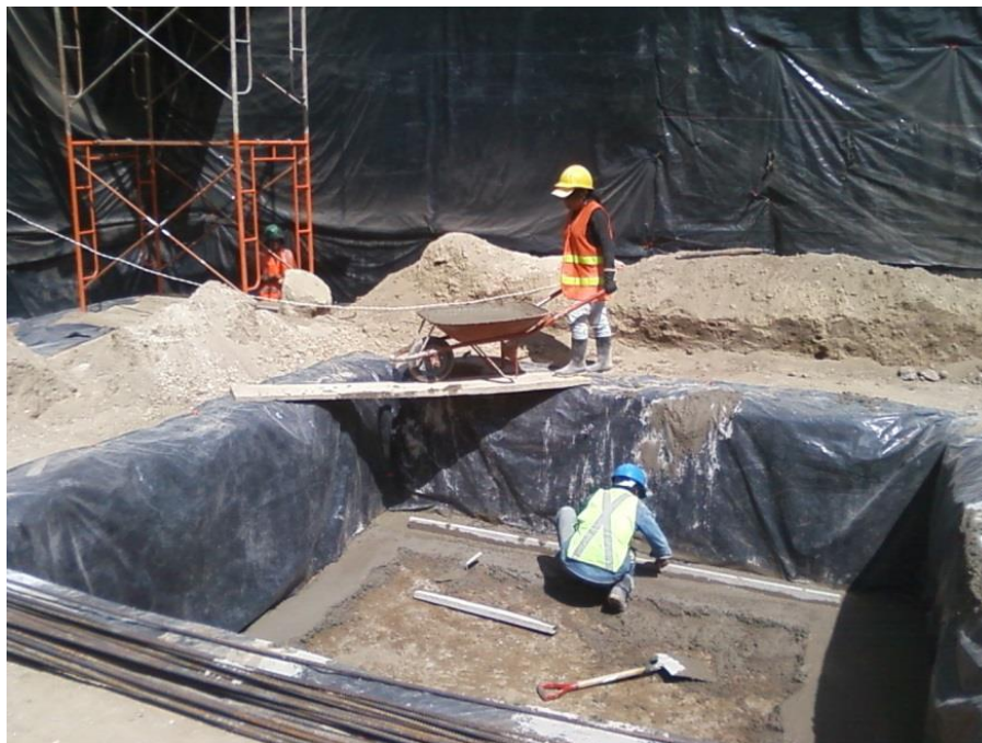
Figura 41: Fundición de contrapiso
