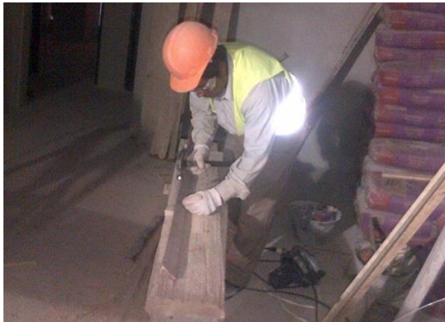
Figura 56: Trabajos de carpintería
