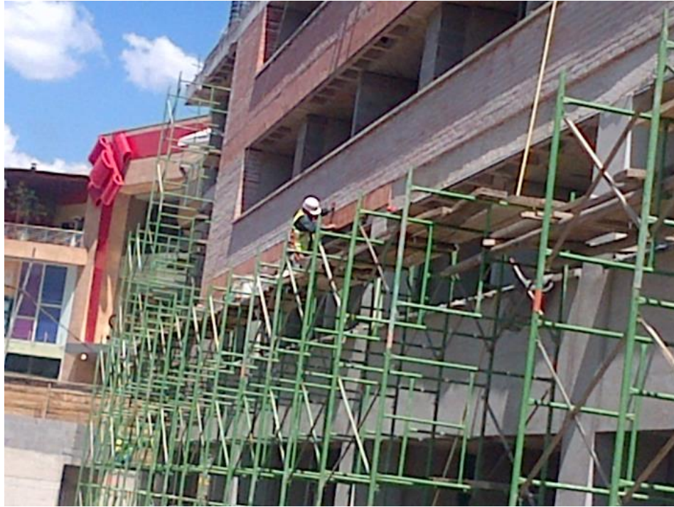
Figura 63: Colocación de fachaleta
