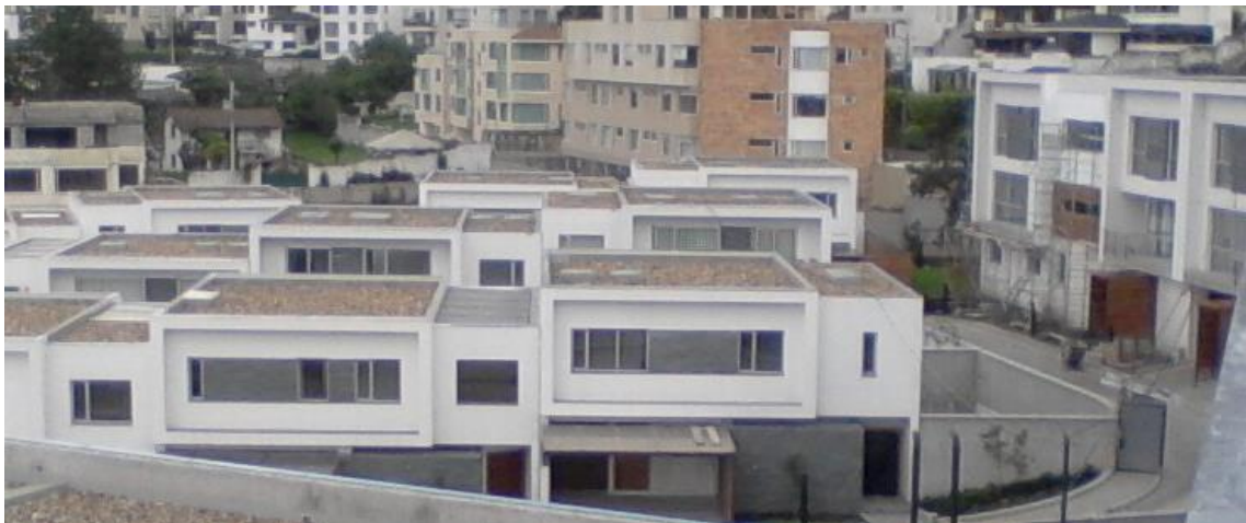
Figura 30: Urbanización Plaza del Rancho, casas y departamentos
