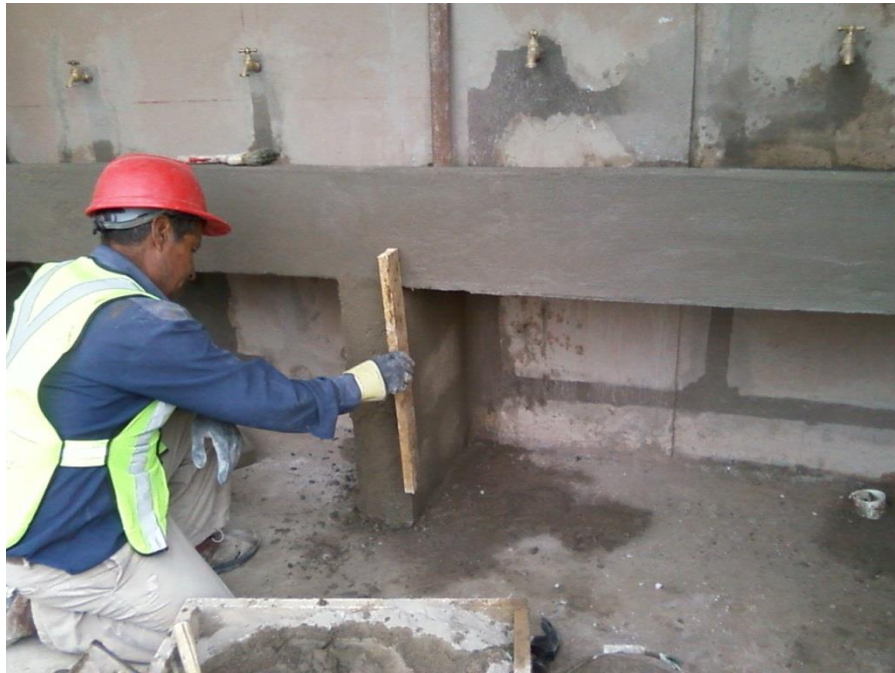
Figura 49: Instalación de lavabos temporales
