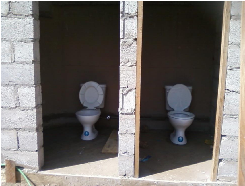
Figura 35: Instalación de baterías sanitarias temporales
