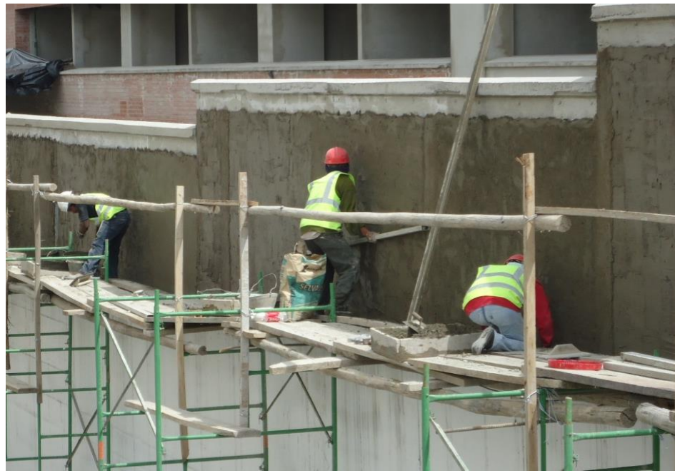
Figura 62: Enlucido de exteriores, andamio montado con pasarela de 0.6m y pasamanos
