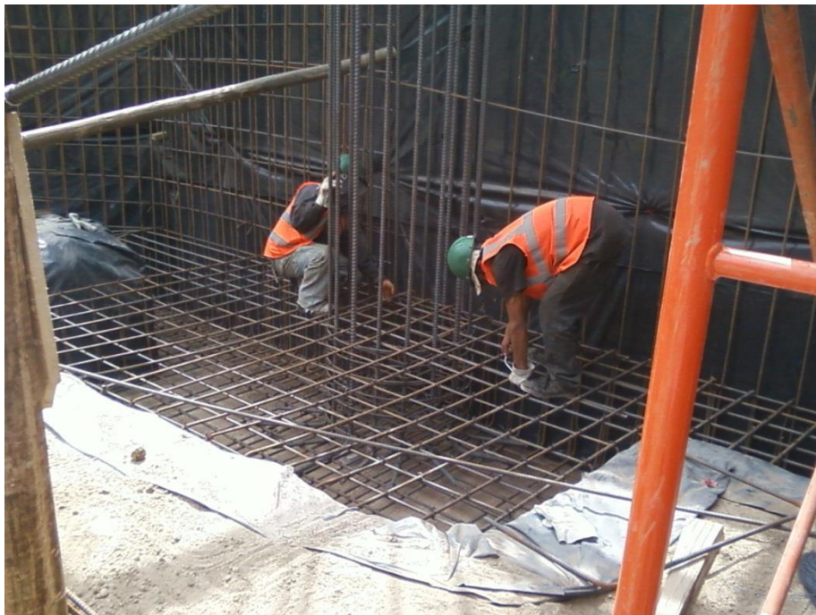
Figura 54: Armado de hierro
