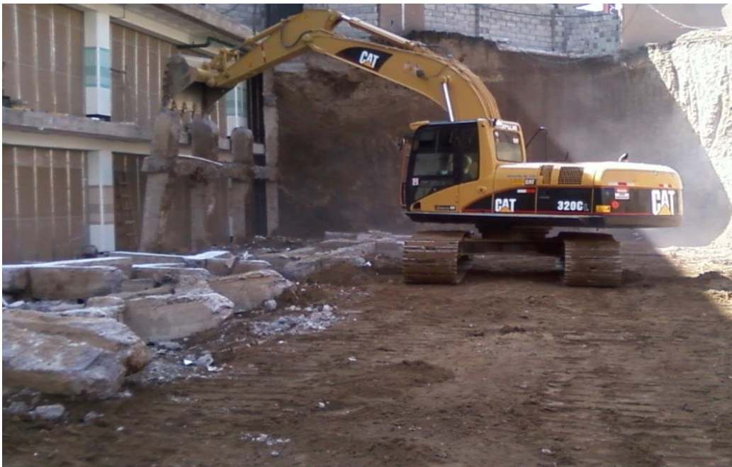
Figura 34: Demolición de estructura, muro de contención, Hospital de los Valles
