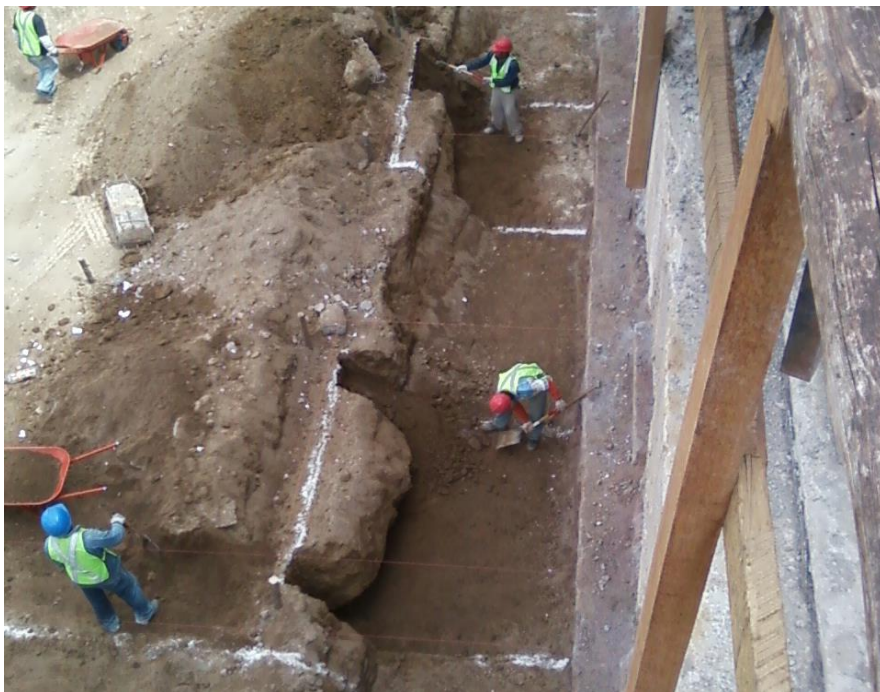
Figura 50: Excavación de plintos
