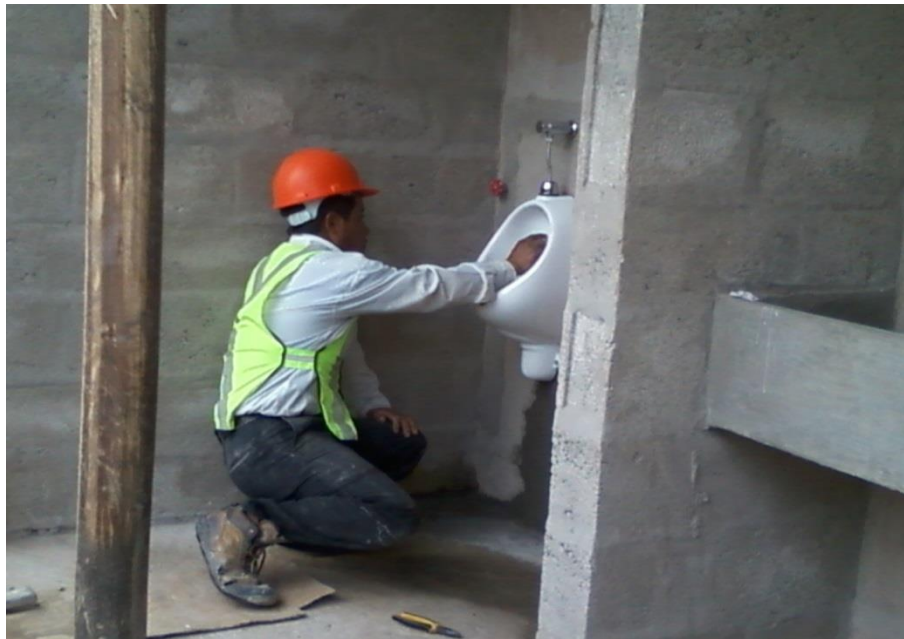
Figura 48: Instalación de baterías sanitarias temporales
