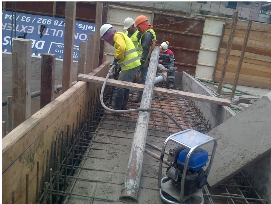
Figura 60: Fundición de losa
