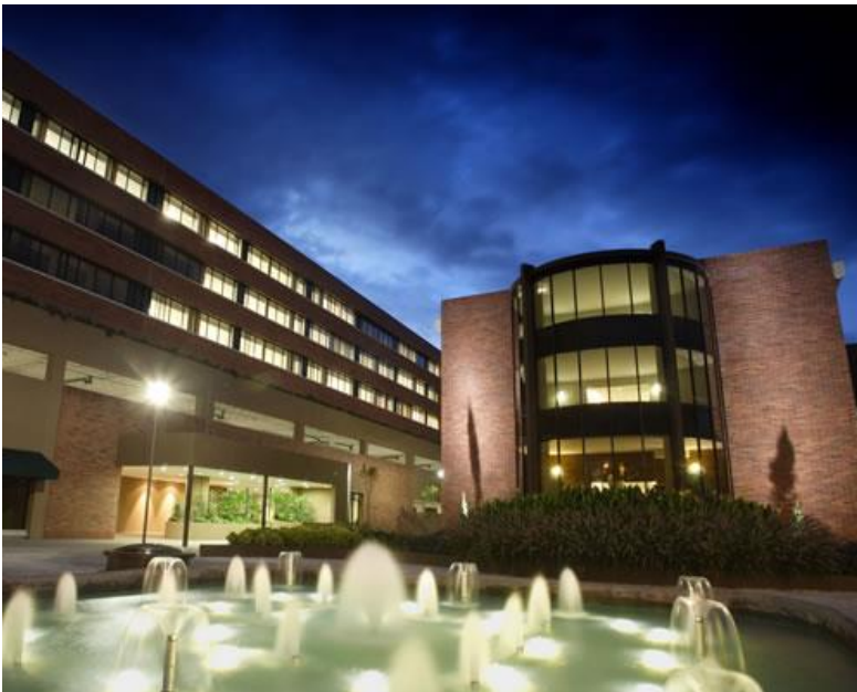
Figura 28: Hospital de los Valles, Cumbayá.
