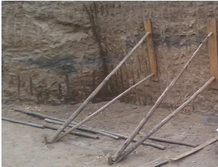
Figura 52: Apuntalamiento de excavación
