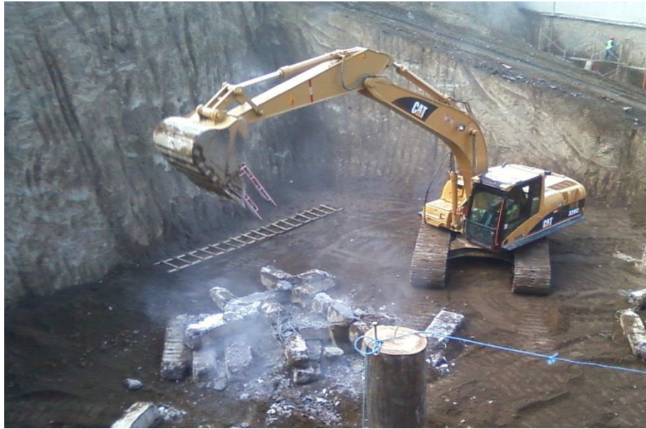
Figura 47: Demolición de estructura
