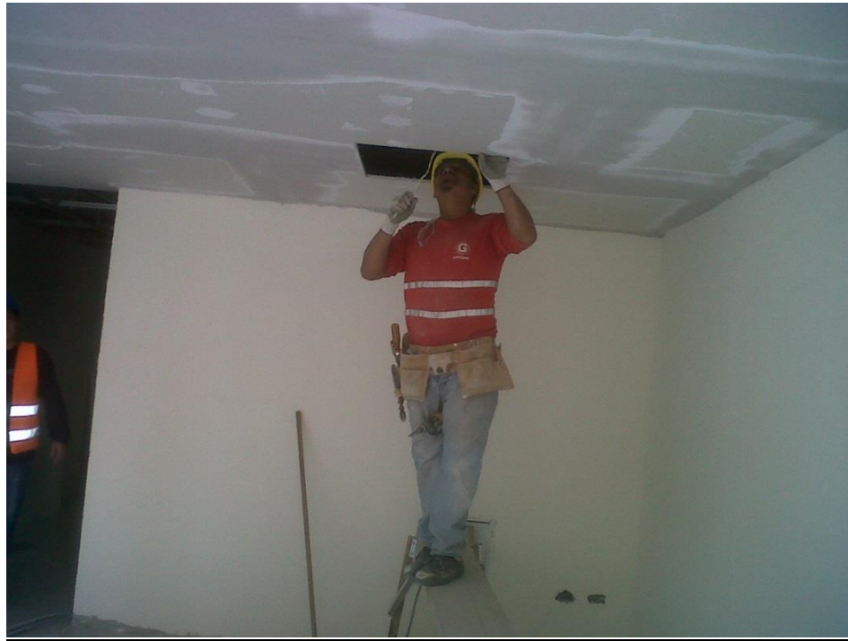
Figura 61: Instalación de gypsum
