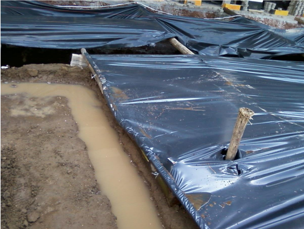
Figura 36: Cubierta de plástico y zanjas de desviación de agua
