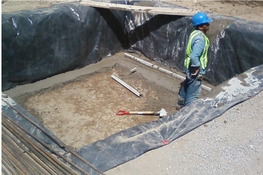
Figura 53: Fundición de contrapiso
