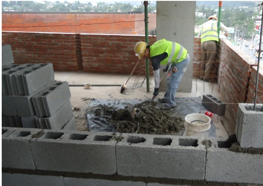
Figura 55: Elaboración de muro de mampostería de bloque
