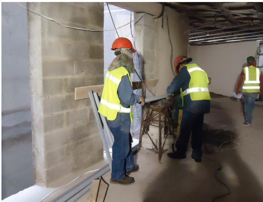
Figura 57: Trabajos de soldadura
