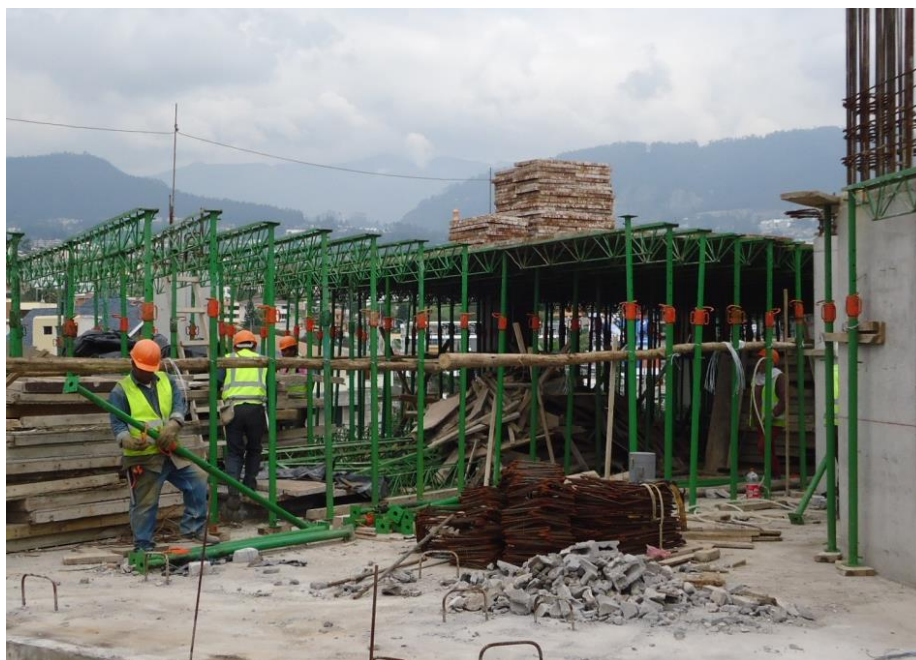
Figura 58: Encofrado de losa
