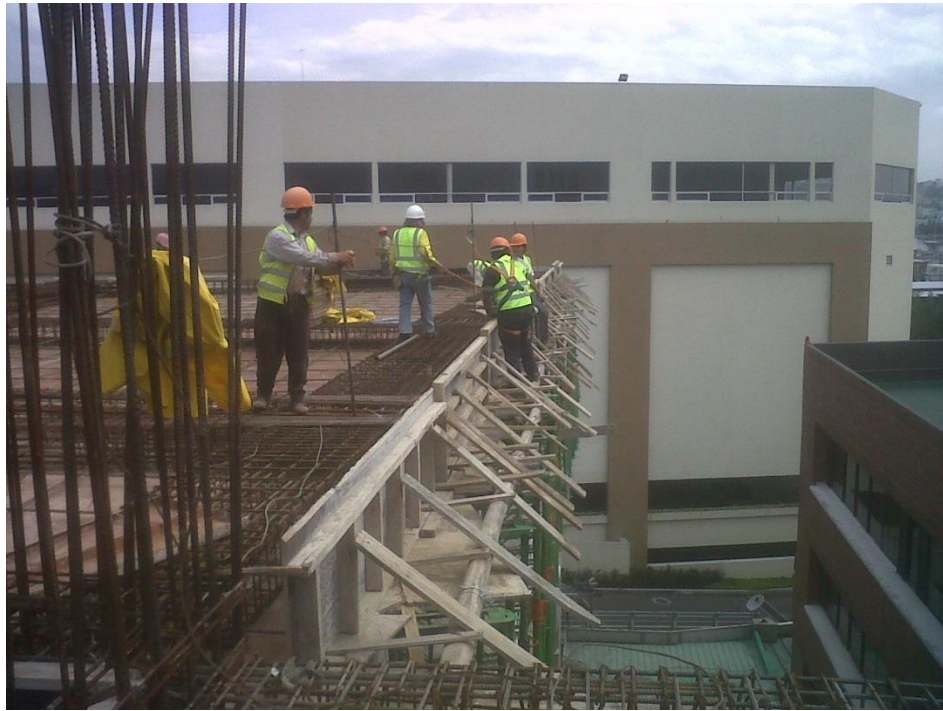
Figura 59: Encofrado de volado de losa
