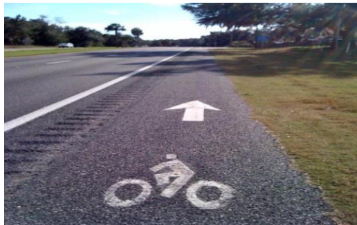
Figura N° 19. Demarcación ciclovía en espaldón con bandas
